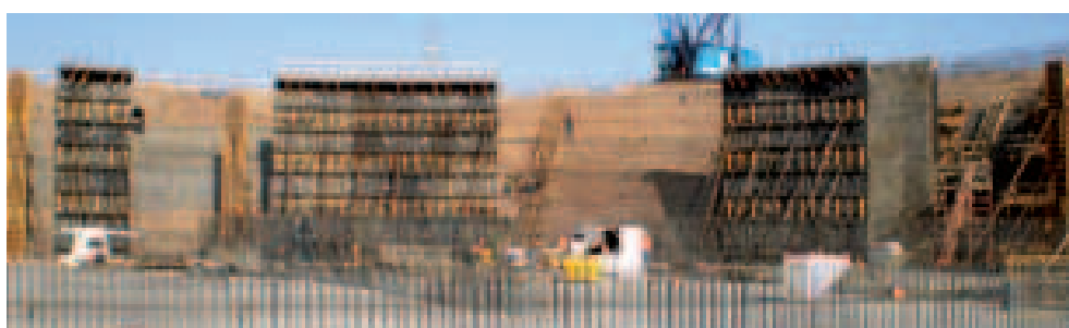
Muro de 32.8" (10 m)
